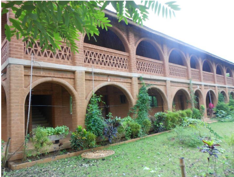
Gebäude der Farm Sichem ebenfalls aus gepressten Ziegelsteinen.
