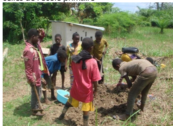
Une séance de travail lors de l'opération remblai
