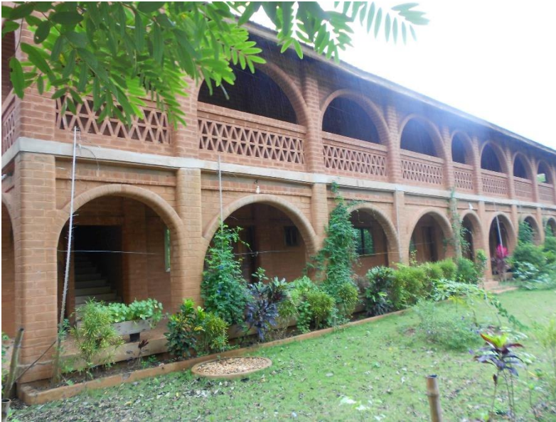
Abbildung 9 Gebäude der Farm Sichem ebenfalls aus gepressten Ziegelsteinen
