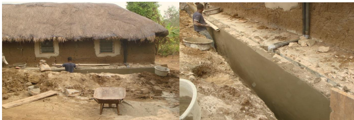
Photo 9 : Vue du bâtiment des visiteurs (à gauche) et travaux d'endiguement de la fondation (à droite)
