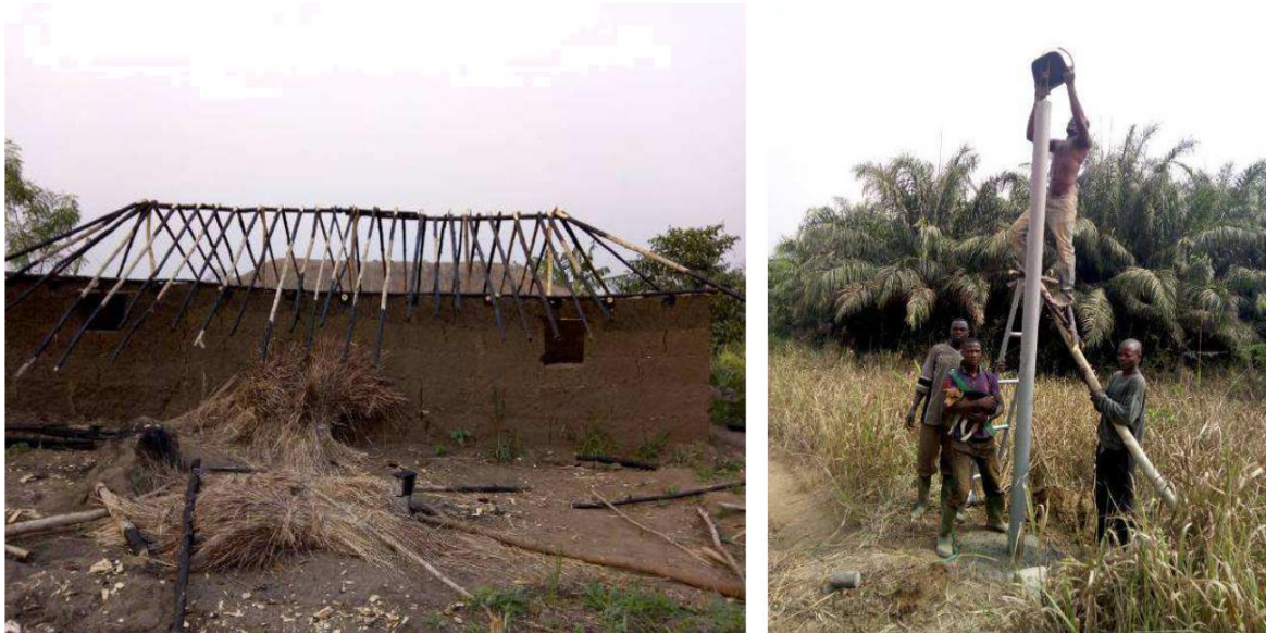
Photo 19: Vers la finition du deuxième bâtiment et coulée de poteau à l'entrée de la ferme
